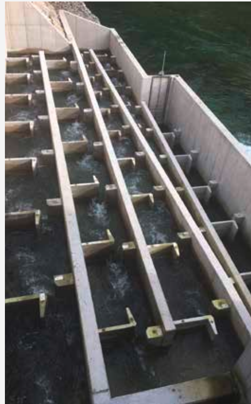
Die neu gebaute Fischleiter an der großen Ybbs
